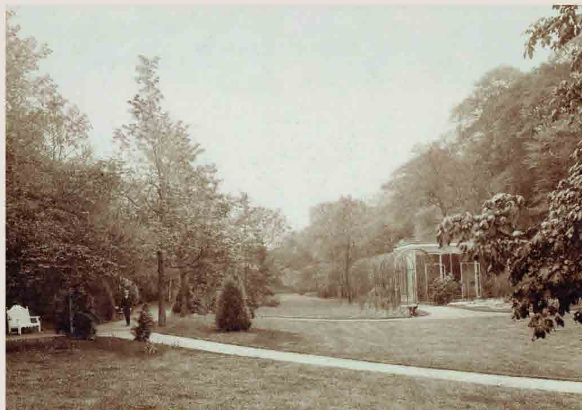
Op deze foto uit 1912 is de orangerie in het park afgebeeld. Deze orangerie was in 1885 gebouwd als winterberging van planten. Later werd dit een theehuis.
