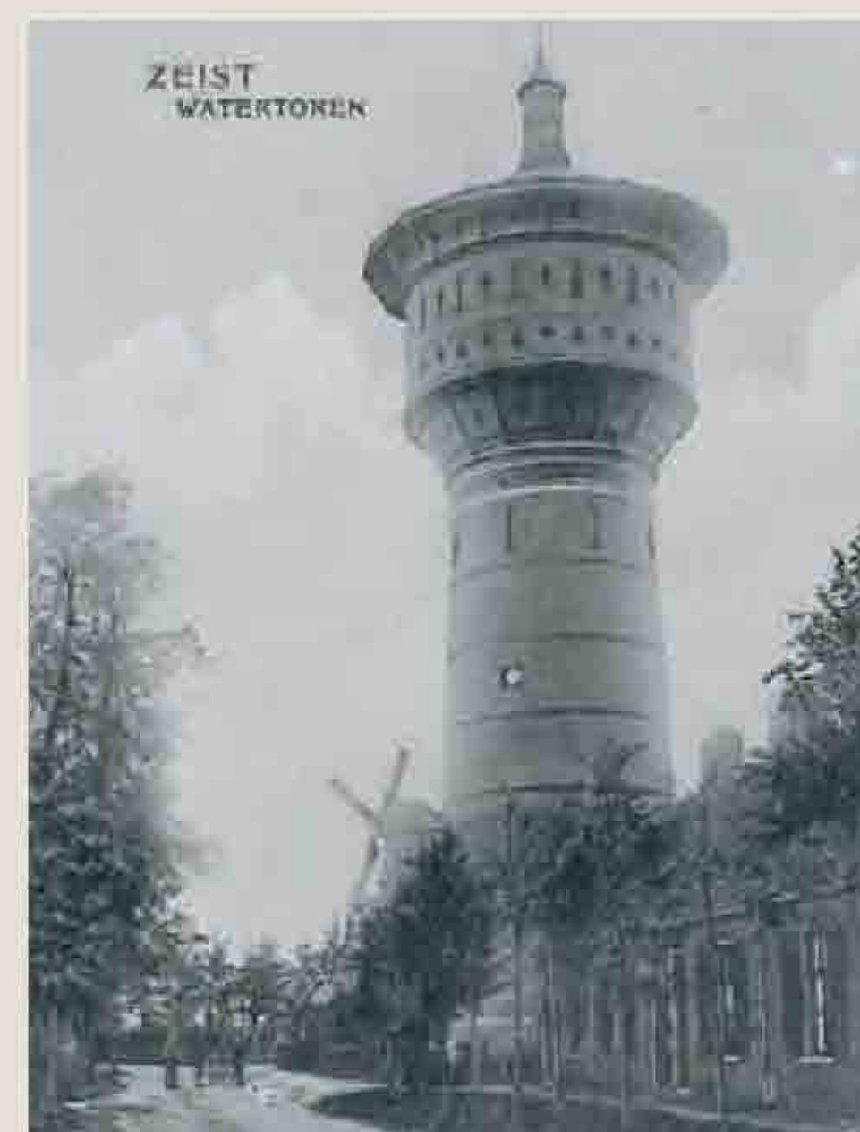
Vroege watertorens zoals die van Zeist, zijn herkenbaar aan een sterk uitkragende toren met een zogeheten Intze-reservoir. In 1883 ontwikkelt de Duitse hoogleraar Otto Intze een reservoir met bolle bodem. Daarvoor hadden reservoirs een vlakke of hangbodem. Juist door een bolle bodem werd het gewicht van het watervat gelijkmatiger over de torenschacht verdeeld.
