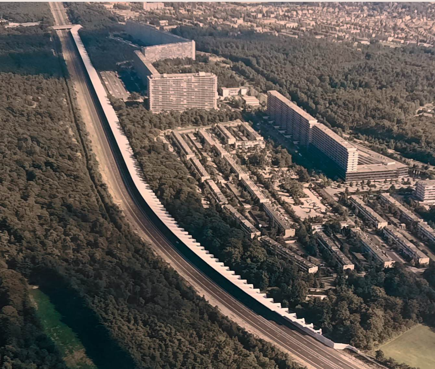
De overhangende geluidswal van de A28 in 1986 (Bron: Zeister Historisch Genootschap)
